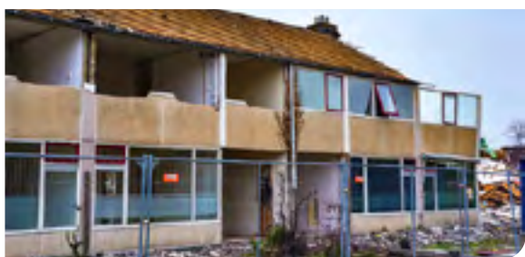
Sloop en vervangende nieuwbouw Heerenveen-Midden
